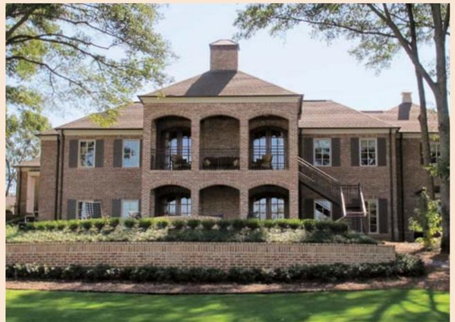
Der „Paper Cut Brick“ ist ein exklusiver Vormauerziegel, der handgeformten oder alten Ziegeln gleicht. Sein Name leitet sich aus dem Entstehungsprozess ab. In der Produktion wird Recyclingpapier auf den gepressten Ziegelblock gerollt. Dieser wird
