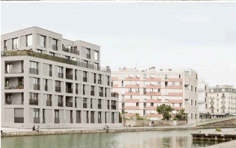
Ort: Pantin, Frankreich Architekten: Avenir Cornejo Architects Copyrights: Schnepf Renou
